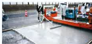
SFRC施工状況
