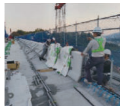
プレキャスト壁高欄の施工
