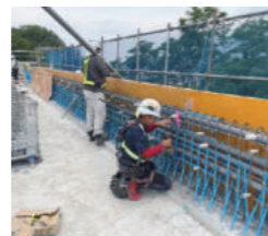
現場打ち壁高欄の施工
