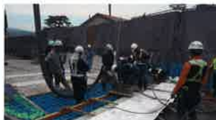
現場打ち床版の施工状況
